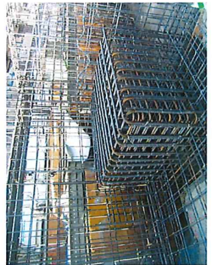
躯体構築 (鉄筋組立)
