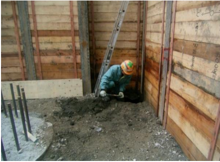
釜場穴掘削(人力)
