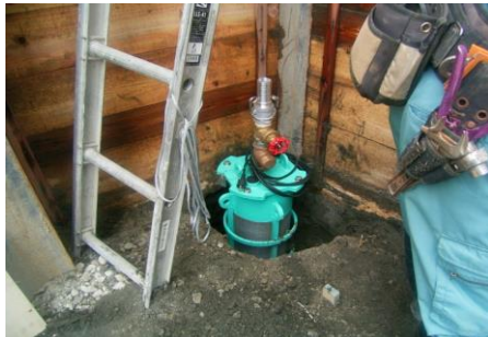
排水ユニット設置(人力)
